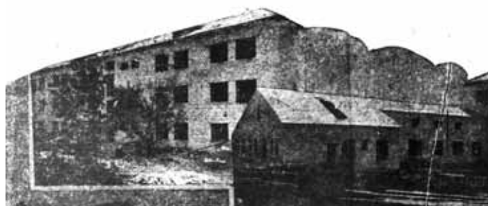
Растет один из лучших рабочих поселков района - поселок ЛСЗ. Начата достройка законсервированного жилого дома и детских. Новый трехэтажный дом будет оборудован электрическим освещением, водопроводом, канализацией. В нем будет паровое отопление. На снимке: слева - достраивающиеся детские, справа - новый дом. Фото из архива редакции.
