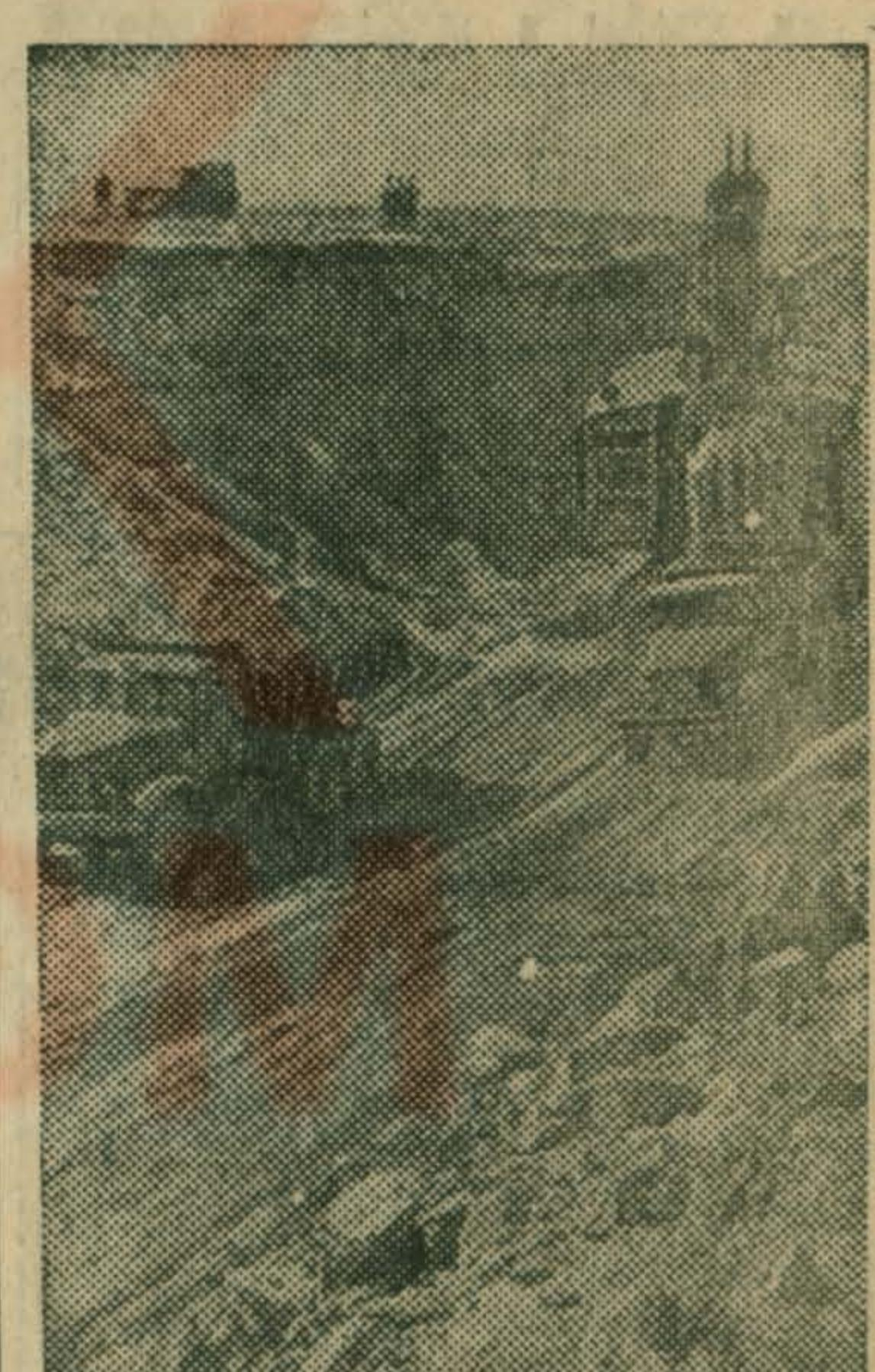
Все дальше в степь уходят строители канала Иртыш—Караанда. Мощный машинный парк стройки состоит из множества экскаваторов, скреперов, бульдозеров. Выемка грунта производится также с помощью взрывчатки.
