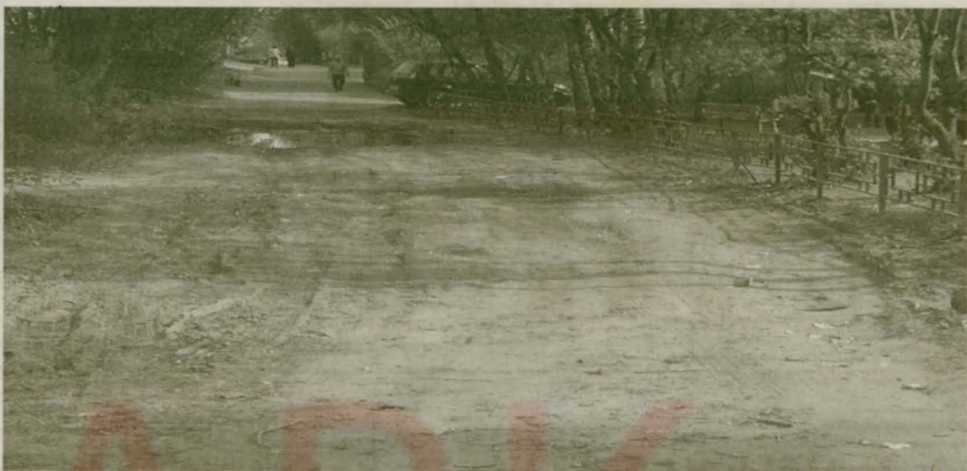
Частный сектор, включая и дороги, находится в еще более ужасающем состоянии. На него просто плюнули.
