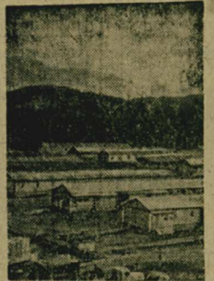
Недавно на Читинском участке БАМа одержана новая трудовая победа — точно по графику путеукладчик Ивана Варшавского прибыл на развал Козар. Поскольку тоннель через Кендарский хребет еще не был готов к укладке рельсов, специалистами управления «БАМстройпуть» в кратчайшие сроки организовали переброску укладочного комплекса через горы, и работы были продолжены. Коллектив Ивана Варшавского продолжает маршрут, быстро продвигаясь навстречу будущей с запада бригаде Александра Бондаря. Их путеукладчик разделяет менее девятсот километров. Перспективы первичные обязанности, строители магистрали наметили новый срок «золотой» стамбовки — первое октября. На СНИМКЕ: поселок Козар, где живут проходчики тоннельного отряда № 12 управления «БАМтоннельстрой». (Фотохроника ТАСС).
