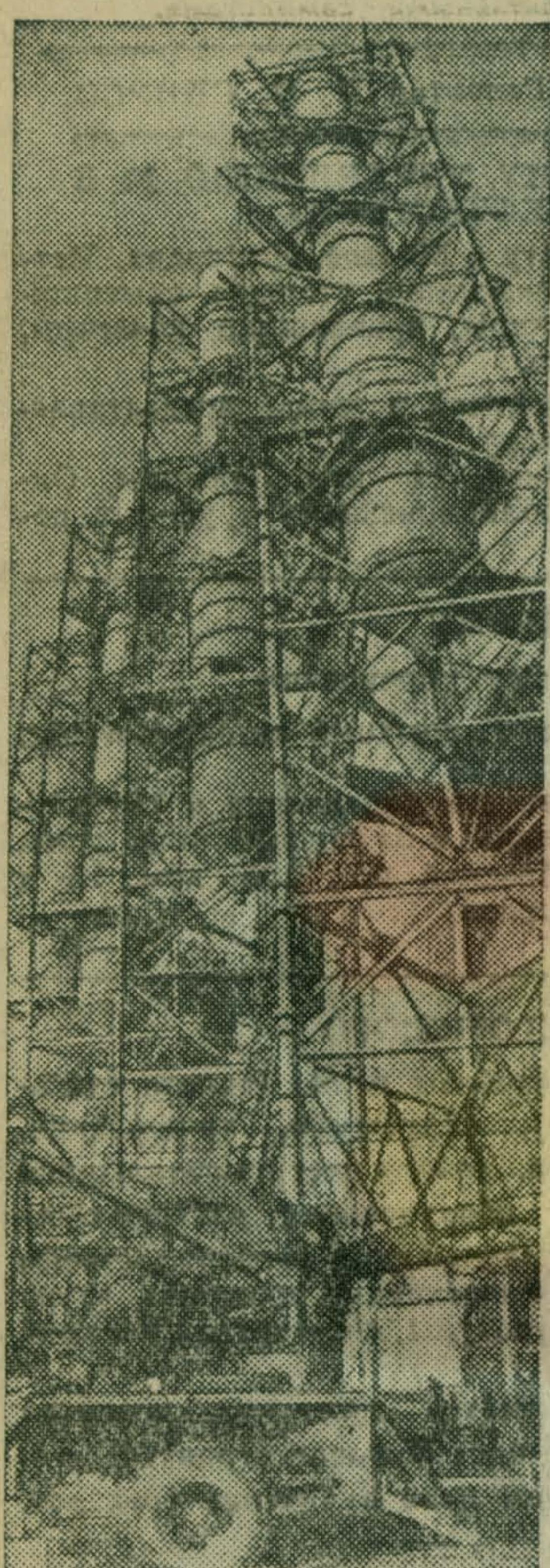
ЭСТОНСКАЯ ССР. По-ударному трудаются на предъездовской вахте строители и монтажники Мадурского химкомбината. В первую очередь войдет в строй цех гранулированного суперфосфата. Стройка вступила в завершающую фазу: идет монтаж и опробование оборудования. Новый цех будет давать в год сотни тысяч тонн гранулированных минеральных удобрений.
