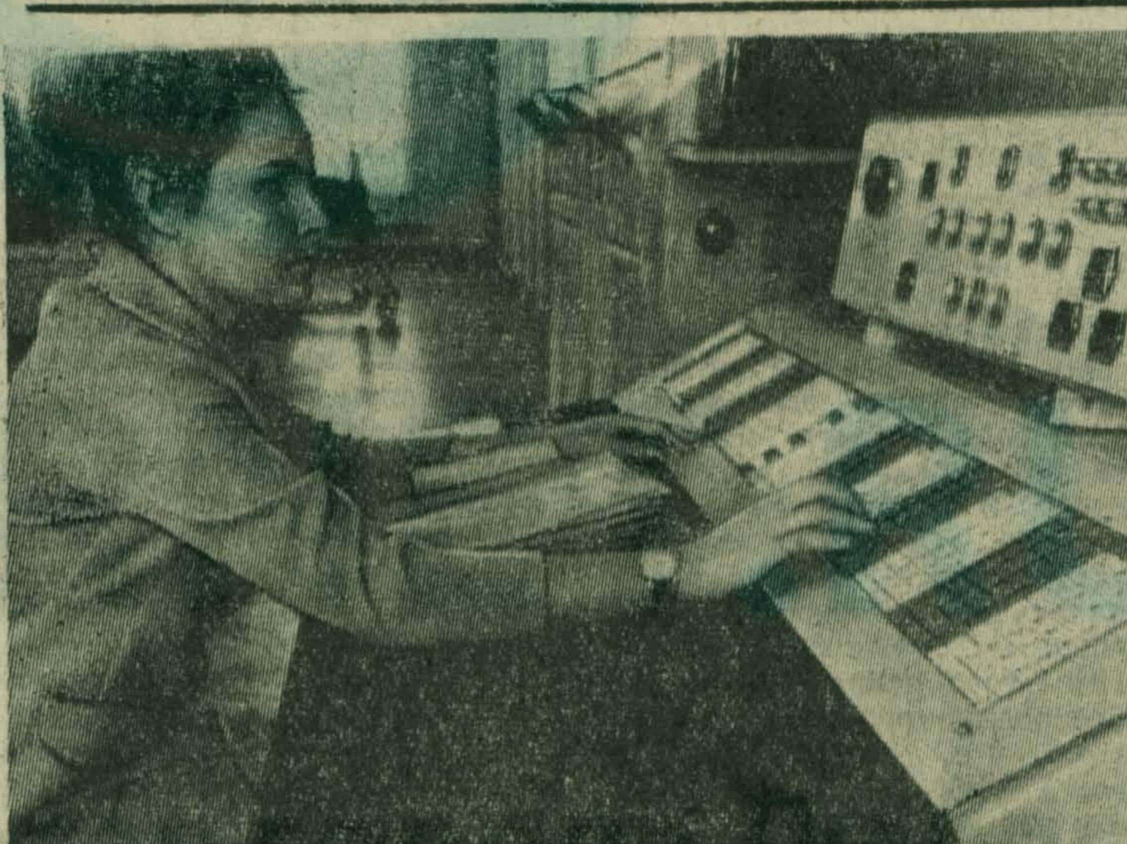
Режим экономии стал неотъемлемой частью организации всех трудовых процессов на Косинской трикотажной фабрике. Орденоносный коллектив использует для этой цели самые современные достижения науки и техники. Так, в закройном отделении установлена мерильно-резальная машина для безостаткового края. Расчет оптимальных вариантов раскроя ткани производится на электронно-вычислительной машине ЭМРТ-2.
