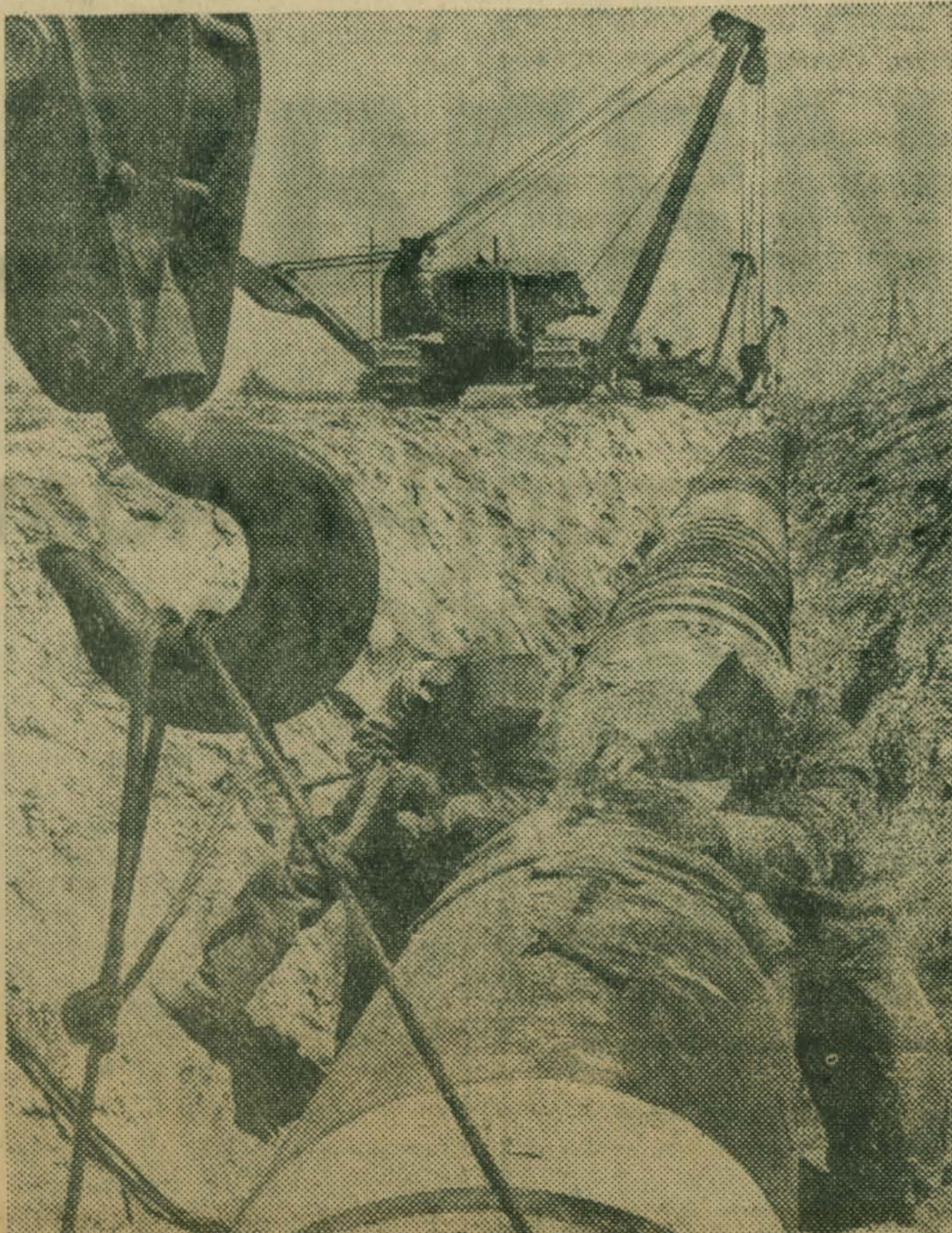
На снимке: сварка стыка трубопровода «Дружба»
