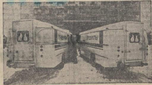
Горьковская область. На Павловском автобусном заводе созданы два новых специализированных автомобиля — рефрижератор и автофургон с изотермическим кузовом. Предназначенные для перевозки скоропортящихся грузов, они сконструированы на базе машины «ПАЗ-672». В холодильнике рефрижератора в самый жаркий летний день будет —15°. Вторая машина — своеобразный термос. Оба автомобиля вмещают по две с половиной тонны грузов.
