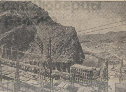
ТАДЖИКСКАЯ ССР. На строительство Нурекской ГЭС заканчивается отсыпка плотины. В нее будет уложено 54 миллиона кубометров грунта. Строители уже уложили более 50 миллионов кубометров. Одновременно ведется монтаж последнего, девятого агрегата станции, мощностью 300 тысяч киловатт.
