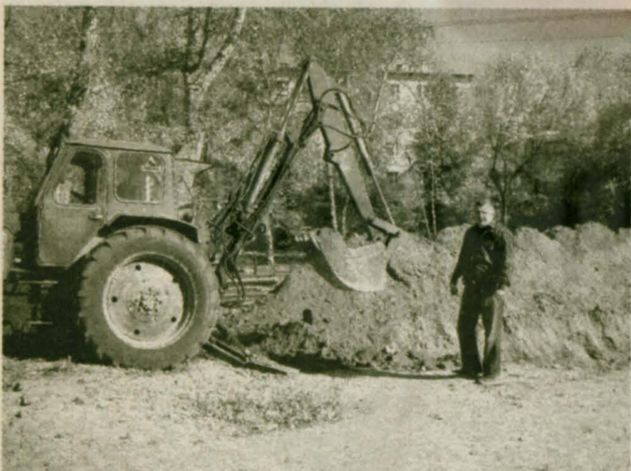
лись стальные современные трубы марки ППУ. Закладывались по 4 трубы (3 диаметром 159 мм и 1-133 мм). Начальник котельной Н.И. Козлова и исполняющий директор ООО «Теплострой» В.А. Усанов заверяют, что теперь в домах станет теплее. Они постоянно находились у траншеи и следили за ходом работ. Спасибо генеральному подрядчику ООО «Жилстрой» в лице В.В. Кулентьеву за эту работу.
