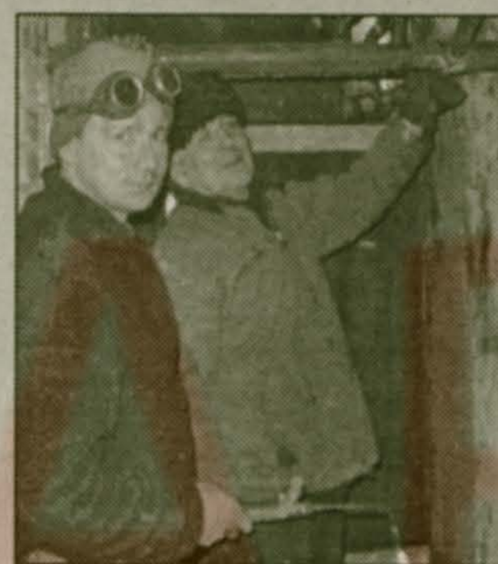
Работники РЭУ-2 газосварщик А.Р. Кучук и слесарь С.П. Лаврентьев проводят ремонт розлива горячей воды на улице К. Маркса, 117/13.
