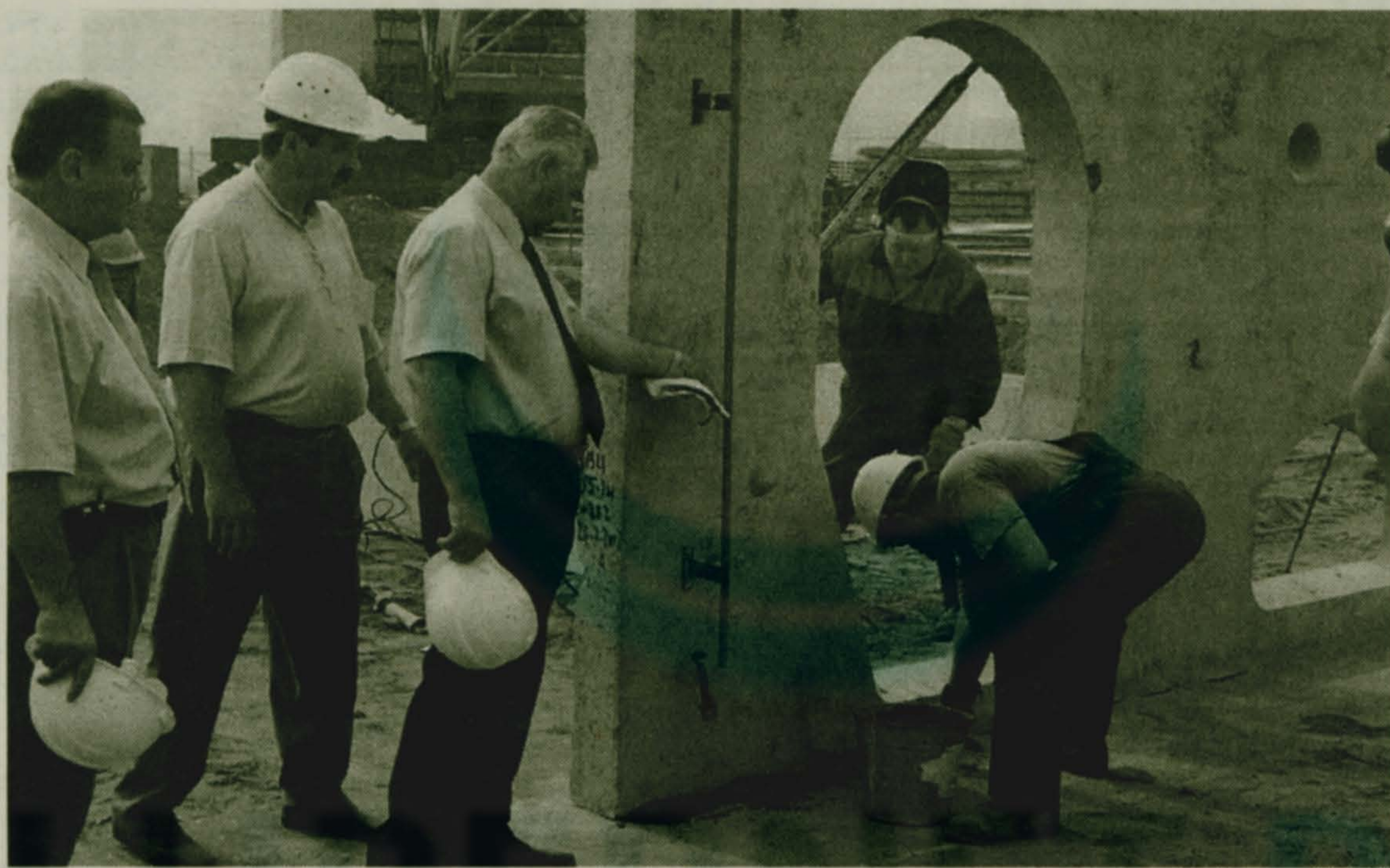
Глава района С.И. Гусев, генеральный директор ООО "ЛИСКстрой" В.М. Юдин, заместитель председателя правительства МО - министр строительного комплекса МО А.В. Горностаев: установка первой панели жилого дома корп. 28, мкр. 6 "Красная Горка".
