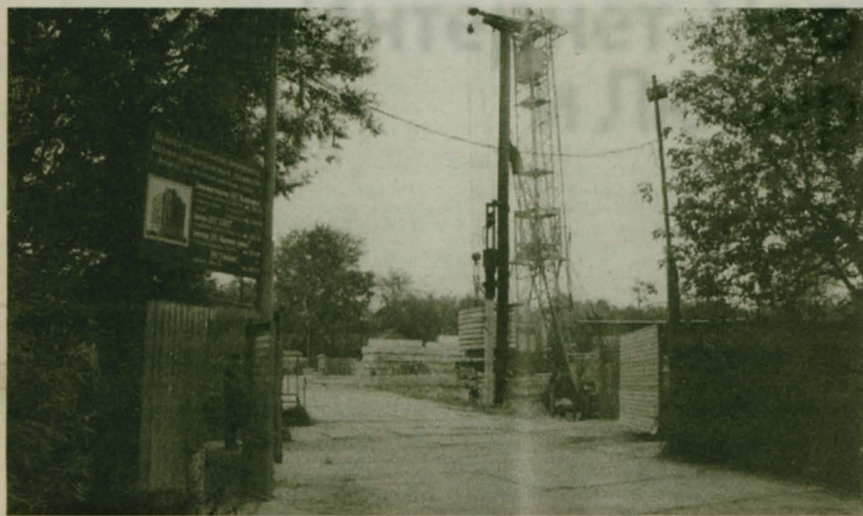
Строительство жилого дома корп. 17 на углу улиц Коммунистическая и Шевлякова (инвестор ООО "Стройсоюз").
