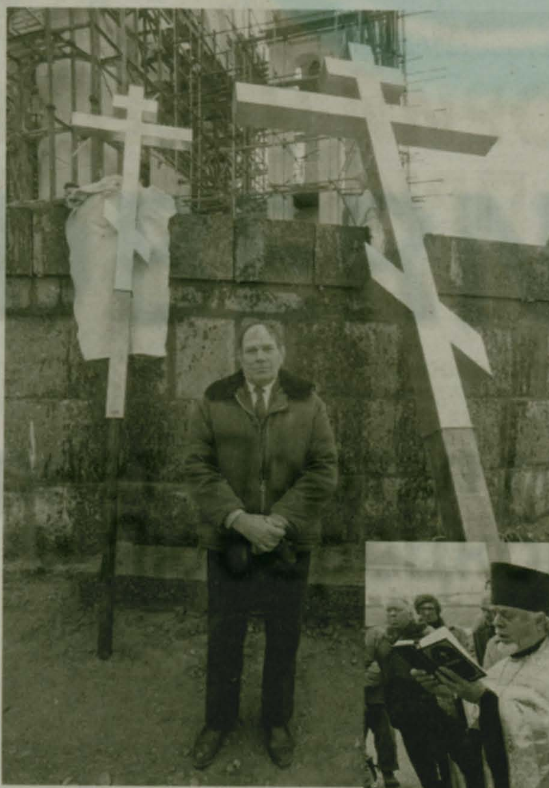
▶ На фоне строящегося храма. Кресты уже позолочены и освящены
