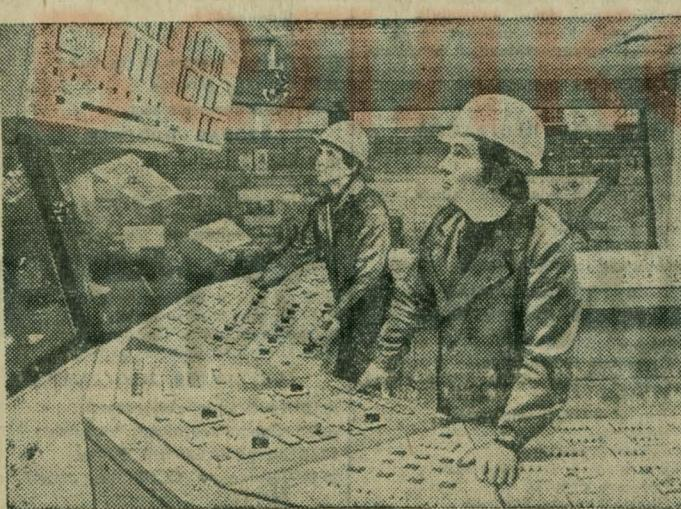
Липецк. На Новолипецком металлургическом заводе завершено строительство первого этапа первой очереди цеха холодной прокатки углеродистых сталей производительностью 1 миллион тонн стального листа в год. Основной процесс так называемой бесконечной прокатки полосы. Получен первый прокат. Вся технологическая цепь поставлена на автоматический режим.
