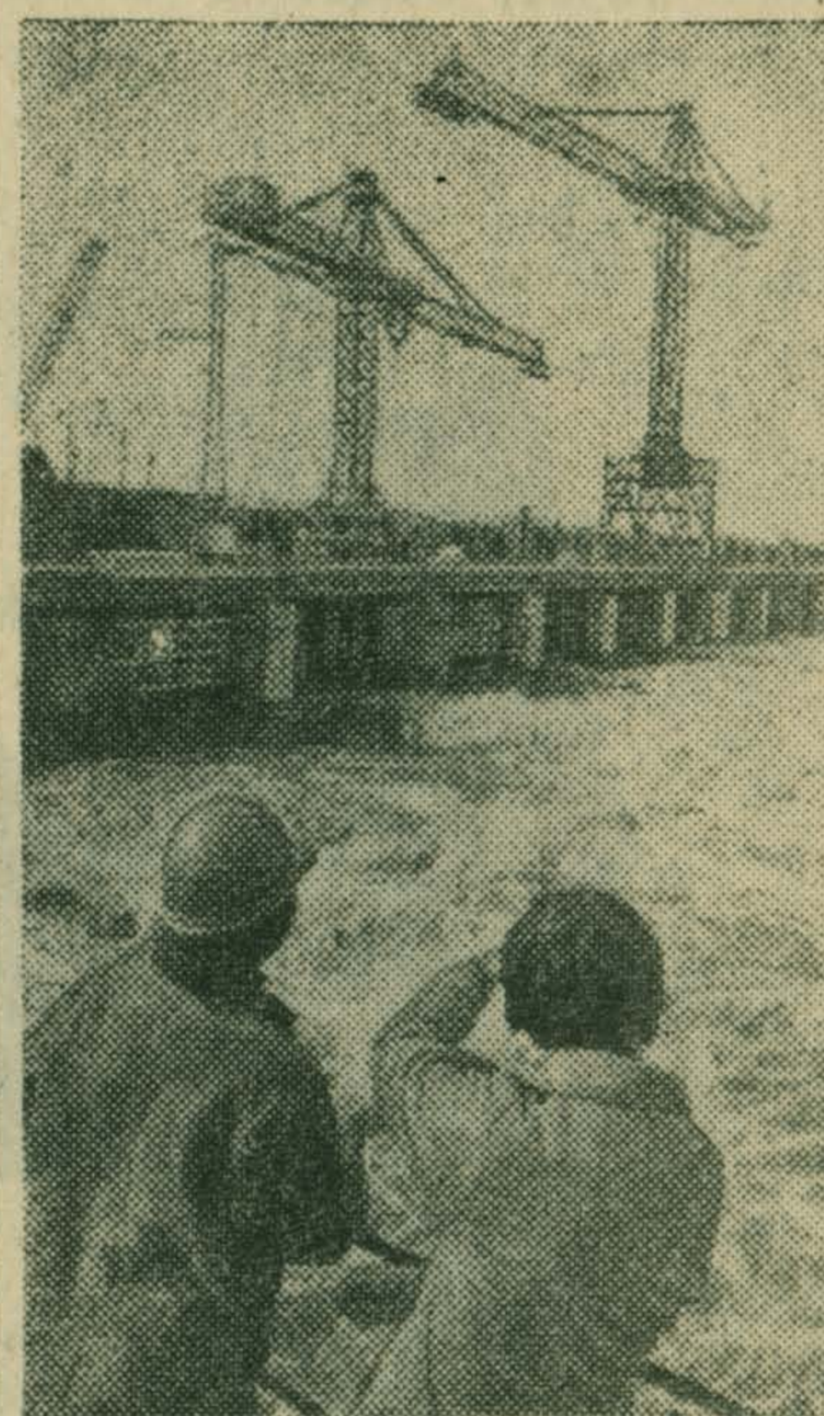
ЧУВАШСКАЯ АССР. Полным ходом идут работы на строительстве Чебоксарской ГЭС. Уже действуют первый энергоблок, два шлуза.
