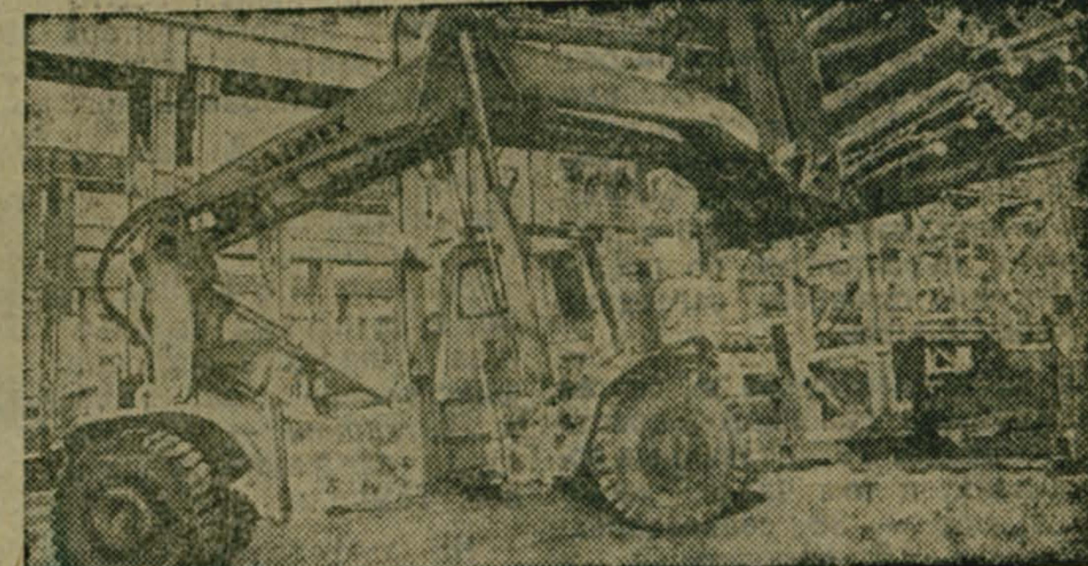
Киров. Каждый десятый железнодорожный вагон высвобождается при новом методе отгрузки продукции на Кировском шинном заводе. Это стало возможным благодаря созданию поочной технологической линии пакетирования грузовых шин. Сконструированный специалистами завода станок обеспечивает подачу шин и формирование пакетов для погрузки в вагоны. В результате полностью исключен ручной труд, пакетирование увеличено по полезную площадь загрузки вагона, сократилось время простоя под погрузкой.
