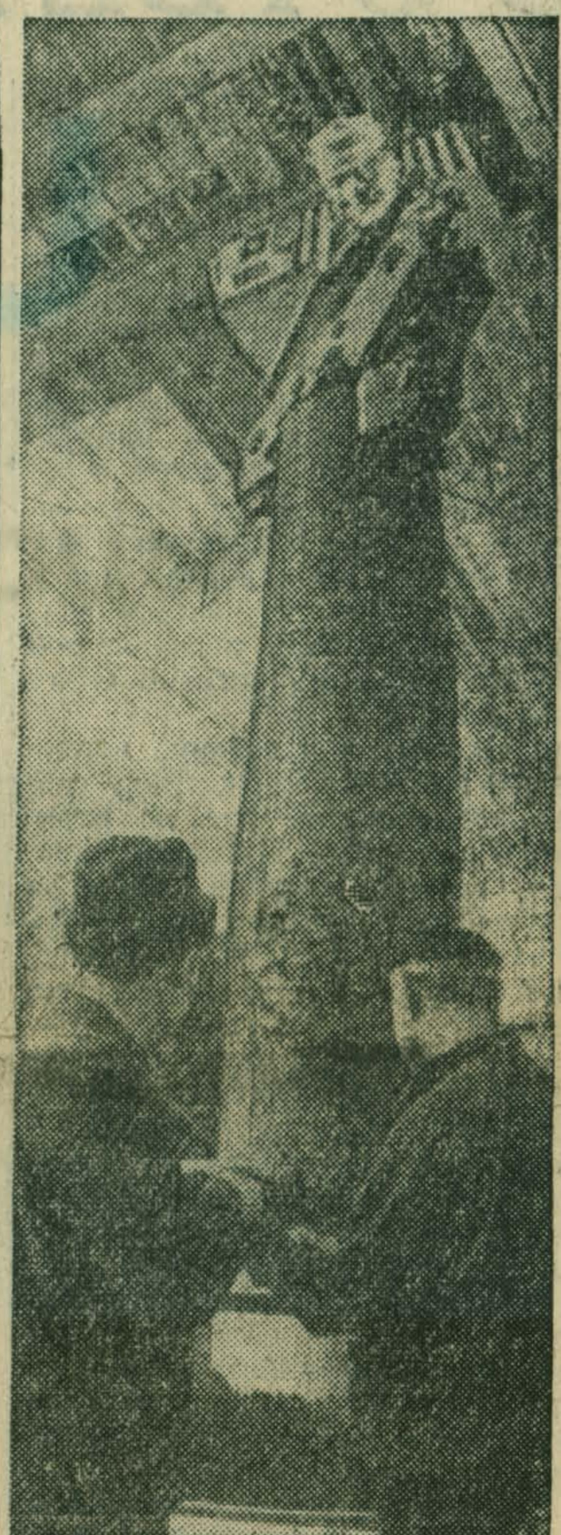
ЛЕНИНГРАД. Большую трудовую победу одержали металлурги Ижорского завода. Здесь достигнута проектная мощность уникальной печи вакуумно-дугового переплава.
