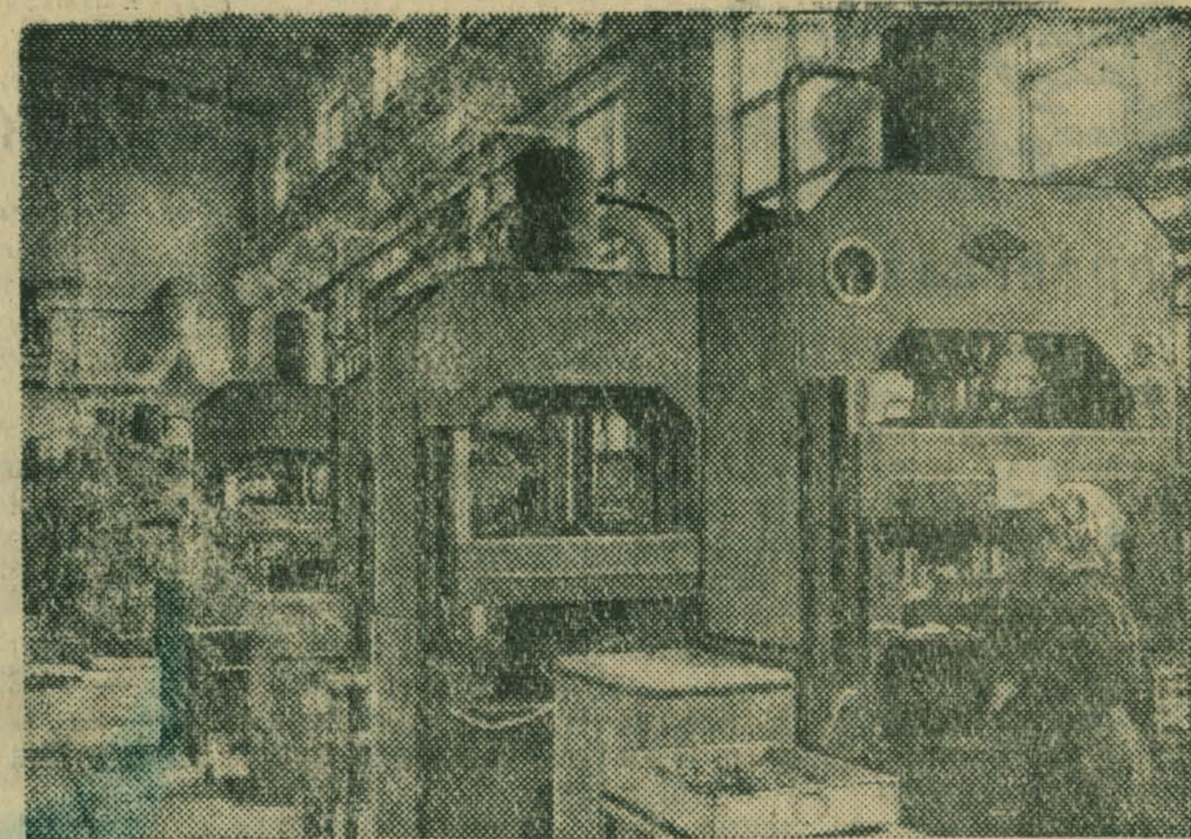
На Свердловском заводе пластмасс один за другим вступают в строй новые цехи. Недавно на предприятии пущен прессовый цех. В его просторных и светлых пролетах установлены высокопроизводительные прессы мощностью до двух тысяч тонн. Цех выпускает изделия для радиоэлектротехнической и машиностроительной промышленности.
