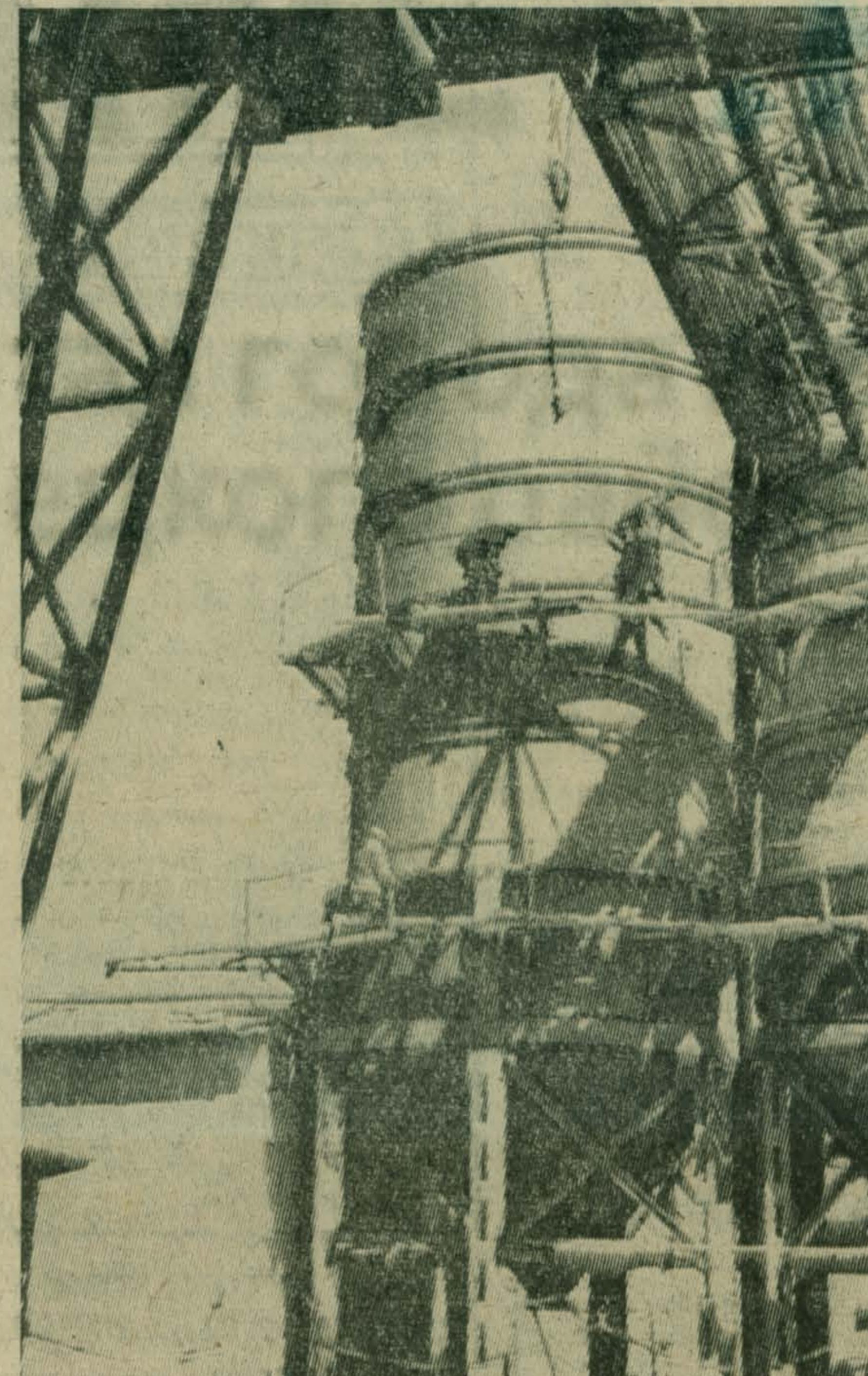
На территории фирмы «Строитель» завершено сооружение новых емкостей для хранения цемента. Сейчас строители работают над монтажом шнеков и другого оборудования.
