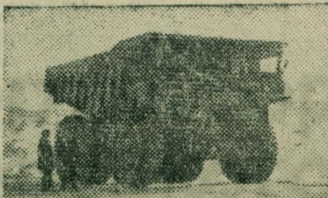
БЕЛОРУССКАЯ ССР. В Заславльском карьере проходит испытания самосвал-гигант марки БЕЛАЗ-549 — детище Белорусского автомобильного завода. Длина машины около десяти метров, ширина — около пяти, а высота — четыре с половиной метра. Мощность двигателя 850 лошадиных сил, грузоподъемность самосвала 75 тонн. Автомобиль надежен в эксплуатации и удобен в управлении.
