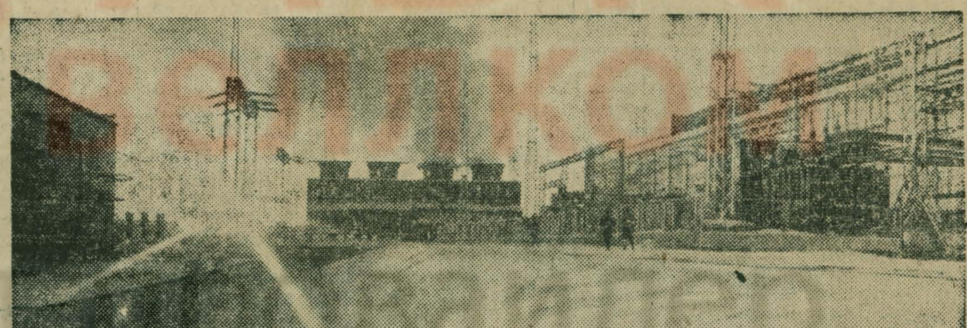
Якутск. Там, где до недавнего времени был пустырь, высятся корпуса Якутской ГРЭС. Здесь действуют три энергоблока, заканчивается монтаж четвертой машины. С вводом ее в эксплуатацию мощность ГРЭС достигнет нескольких десятков тысяч киловатт. Это — единственная в стране станция, работающая на двух видах топлива — жидким и газом. Опыт строительства и эксплуатации Якутской ГРЭС будет использован при проектировании подобных объектов в условиях вечной мерзлоты.
