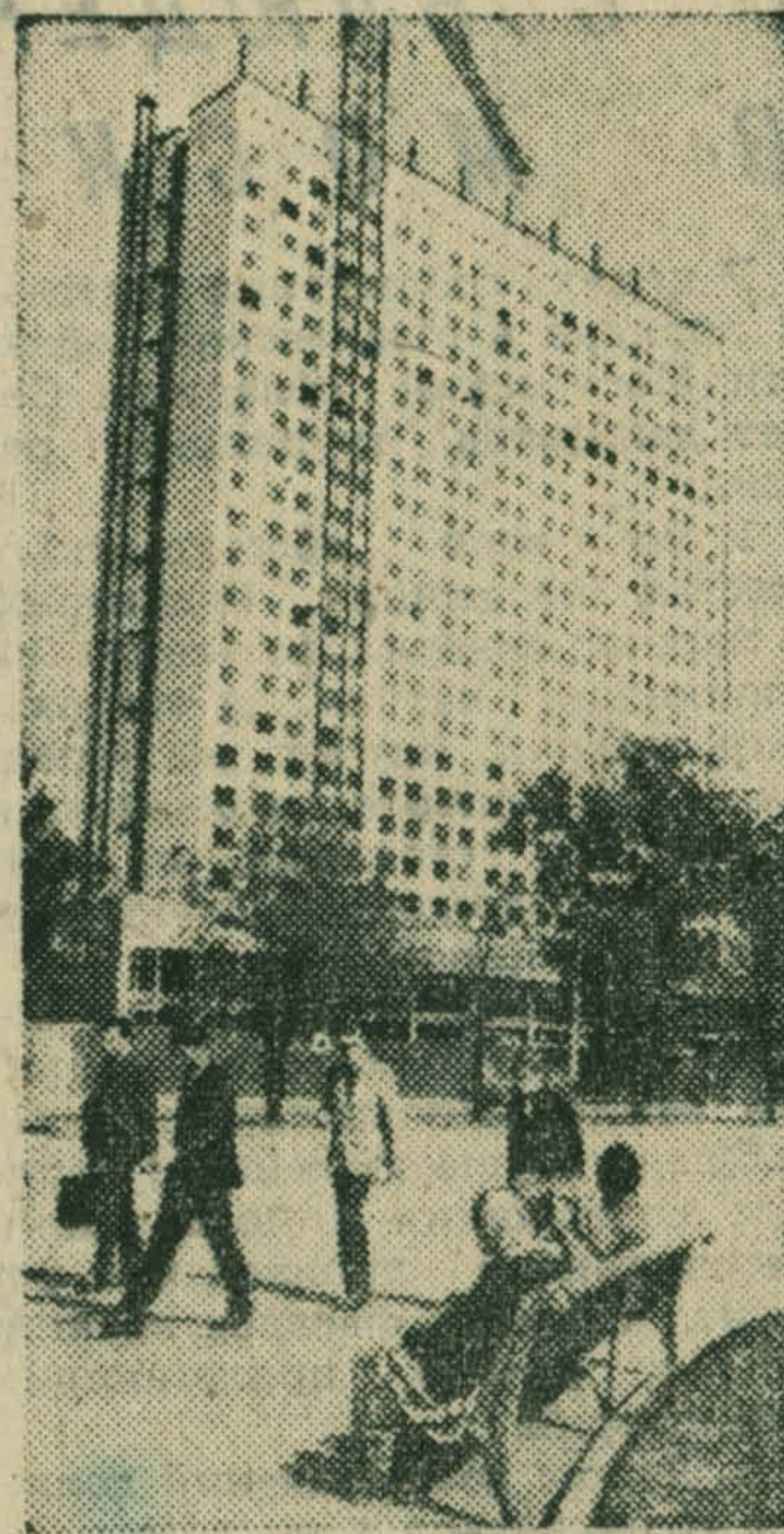
Новосибирск. На площади имени Гарина-Михайловского полным ходом идет строительство самого высокого в городе здания — 24-этажной гостиницы. В ее комфортабельных одно- и двухместных номерах смогут одновременно разместиться 1000 человек. НА СНИМКЕ: строительство гостиницы.
