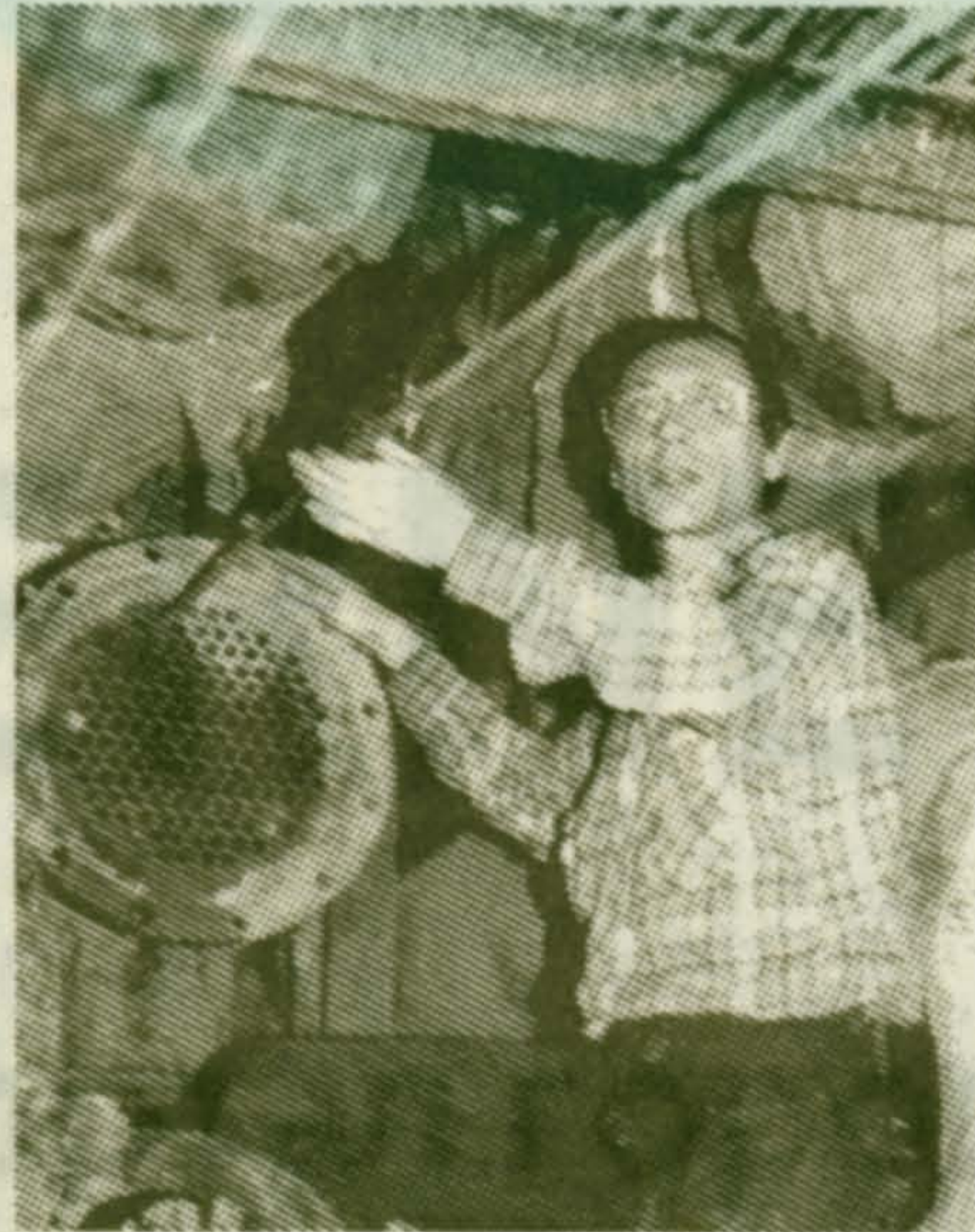
Слесарь по ремонту теплотехнического оборудования А.В. Коняичев за работой
