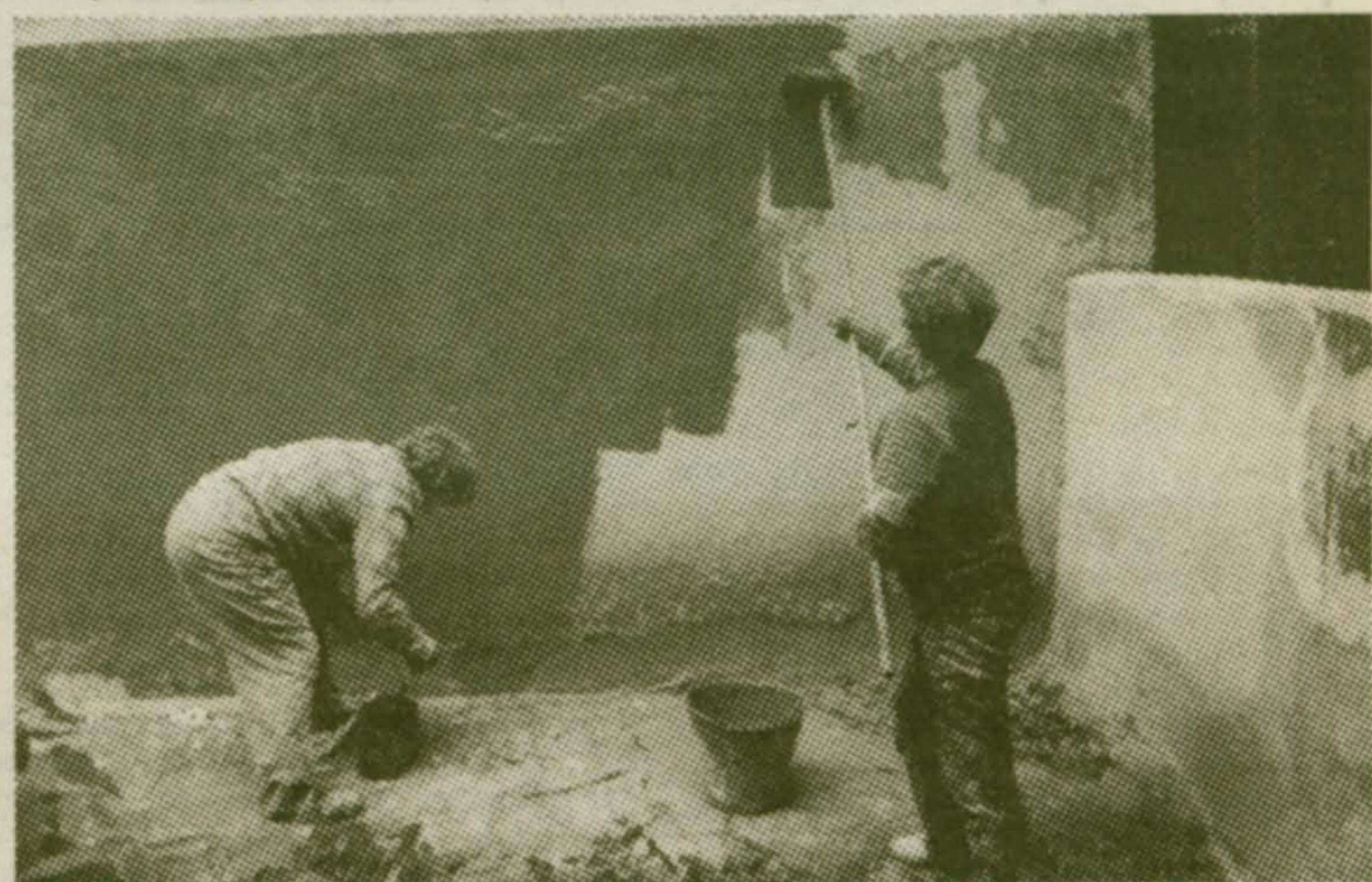
Бригада МП «РОСС» на ремонте цоколя
