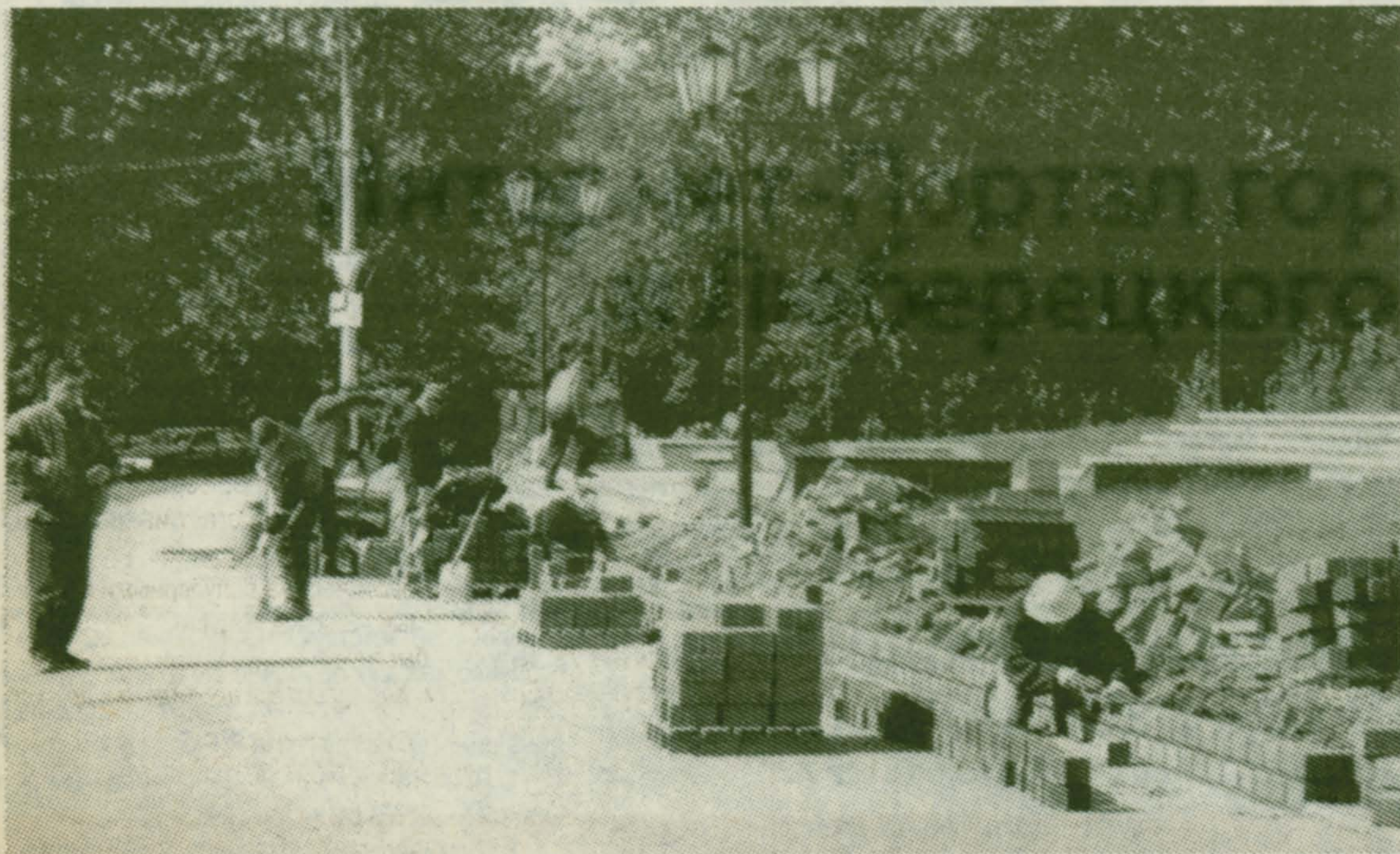
Площадь Дмитрия Донского благоустривают строители фирмы «Итекс»
