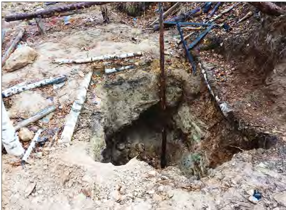
Разведочный шурф
