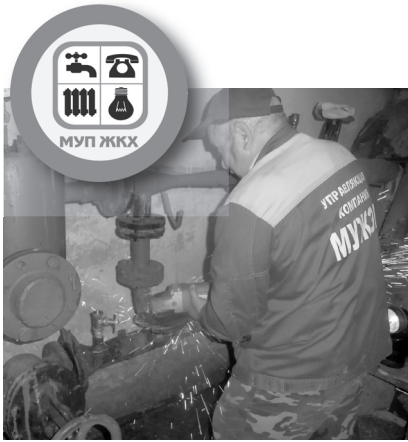
МУП ЖКХ ГП Малаховка устранена течь стояка горячего водоснабжения в квартире в доме
